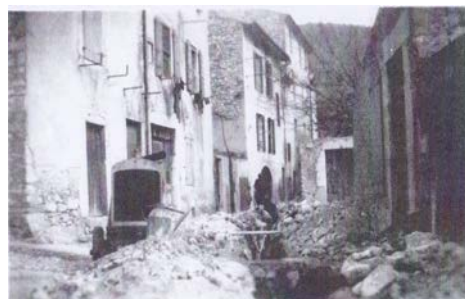
1954 travaux adduction rue Barnave
