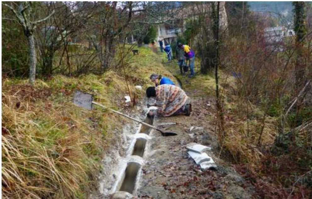
Travaux annuels à la bélière ce samedi 2 mars.
