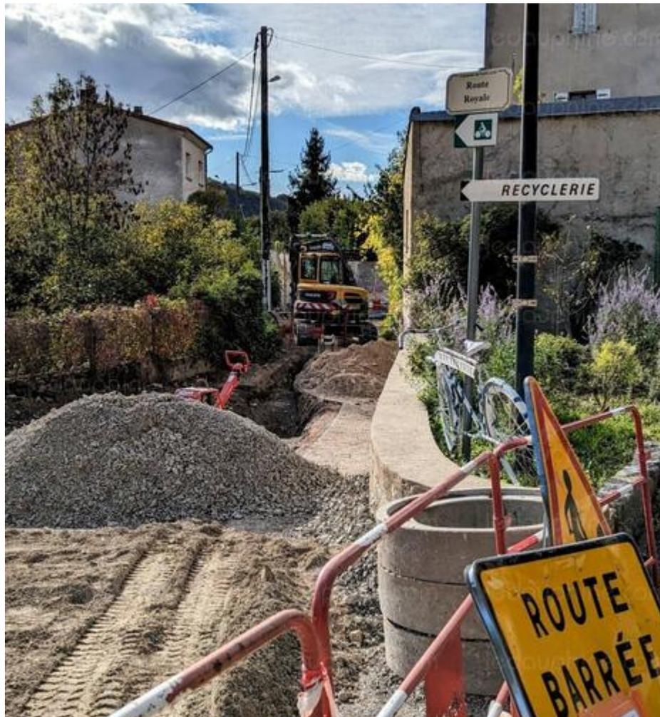
*Des travaux de séparation des eaux pluviales et des eaux usées sont en cours de réalisation sur la route royale, entre le pont du Rieussec et Tourtoiron.*
