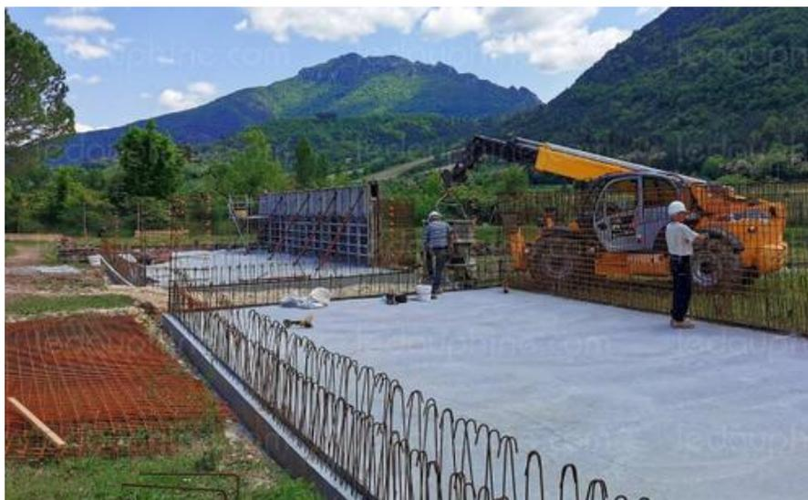
*La construction des bassins de séchage est en cours, la plantation des roseaux se fera d'ici cet été et le traitement par rhizocompostage des boues de la station d'épuration de Saillans devrait être opérationnel à l'automne.*
