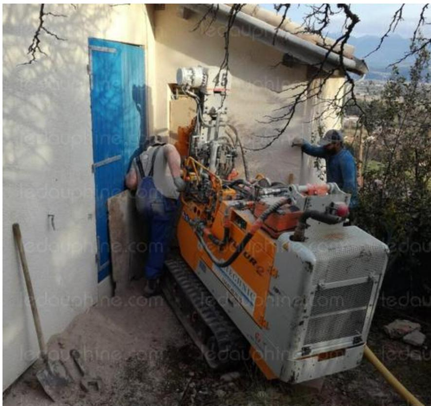
*La mise en place de micropieux pour conforter les fondations des maisons constitue un important chantier. Photo Corinne Gasdon*
