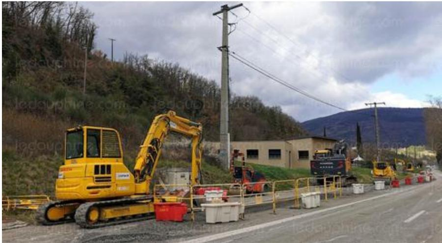
*Pour relier la conduite d'eau potable venant de Blacons à celle de Saillans, une tranchée de 900 mètres de long doit être creusée le long de l'avenue Georges-Coupois depuis le parking de la Magnanerie jusqu'à l'entrée du camping des Chapelains. Photo Le DL /H.B.*
