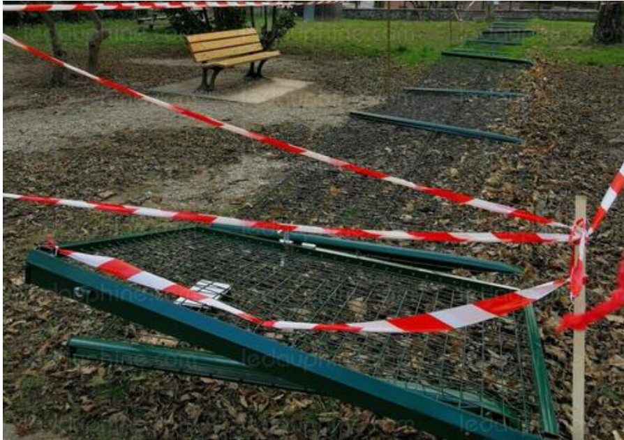
La clôture du jardin public a été pliée jusqu'au sol sur toute sa longueur.
