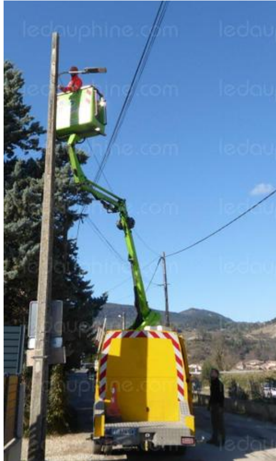
Travaux sur le réseau.
