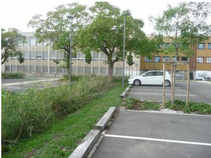
Système de noues pour récupérer les eaux pluviales de voirie. Systèmes sans bordure.
