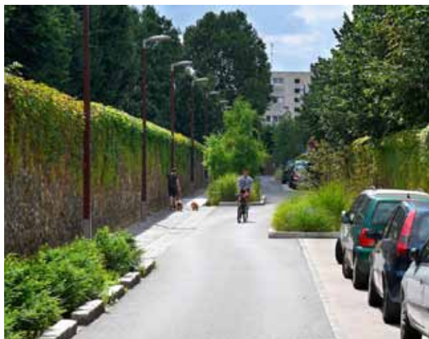
Système de noues pour récupérer les eaux pluviales de voirie. Systèmes sans bordure.
