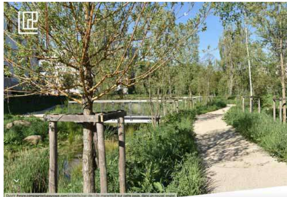
Système de noues pour récupérer les eaux pluviales de voirie. Systèmes sans bordure.
