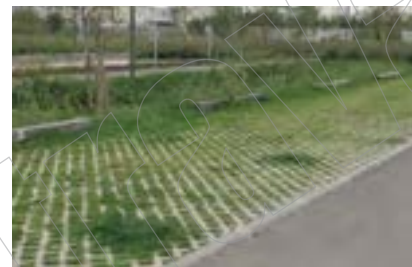
Exemple de stationnement végétalisés / perméables qui permettent l'infiltration des EP
