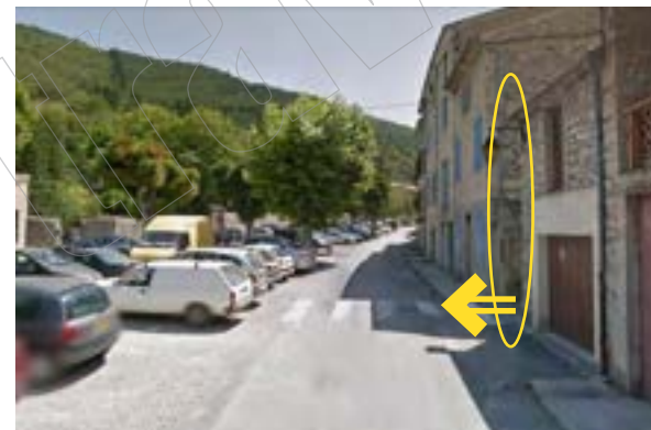
Sortie piétonne centre ancien sur Bd de l'écho illisible
