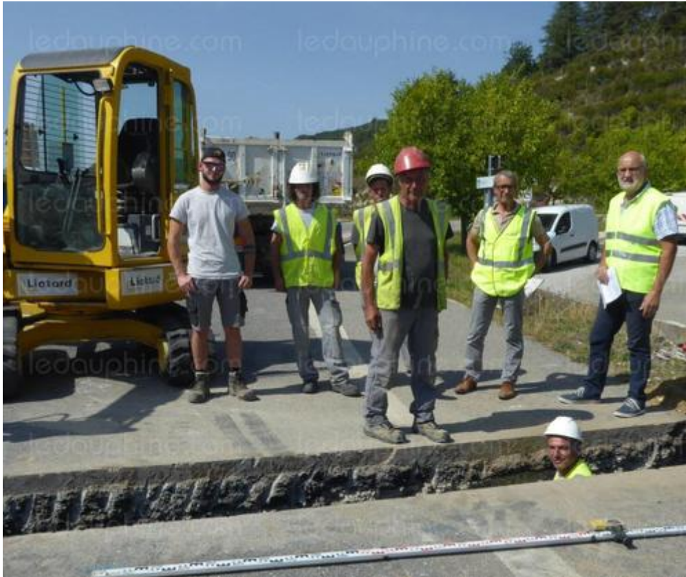
Les élus sur le chantier, mercredi 8 septembre.
