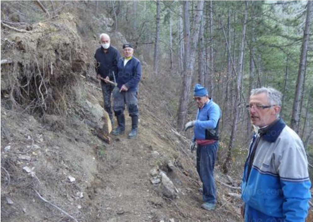
L'équipe sur le chantier.
