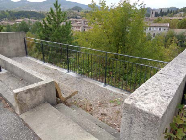
Les nouveaux garde-corps
