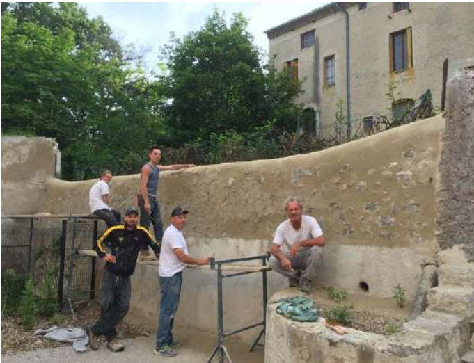
Mi-juin - Réfection du mur au-dessus des maisons bois par l'équipe de BATI26
