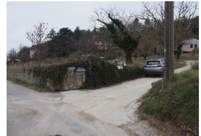
Vue sur le tènement depuis le chemin de Saint-Jean : Un mur de soutènement en pierre est à conserver.
